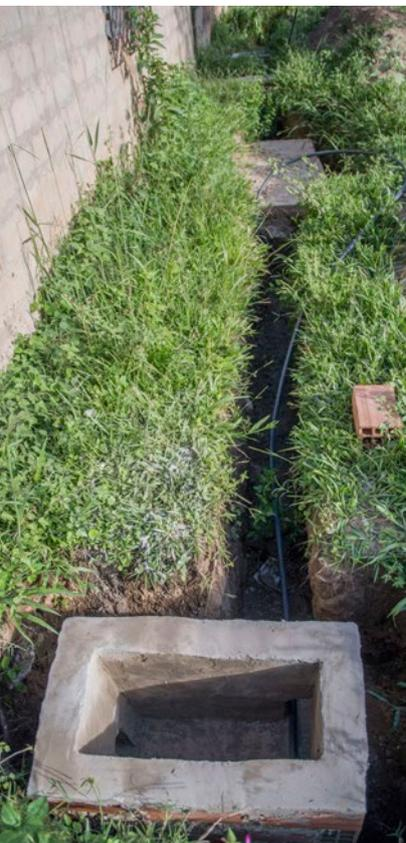
Projekt. Wir standen vor dem Problem, dass die Wasserrohre im gesamten Zentrum langsam an vielen Stellen undicht wurden und das Wasser immer öfter abgedreht werden musste. Deshalb wurde beschlossen, ein neues Rohrsystem zu legen.
